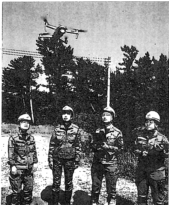
山陰道建設現場でドローンを活用した測量を行う井中組のチーム。5月15日、北条町西園
